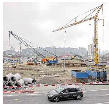
Schöne Aussicht: Baustelle am Seetalplatz. Bild Philipp Schmidli
